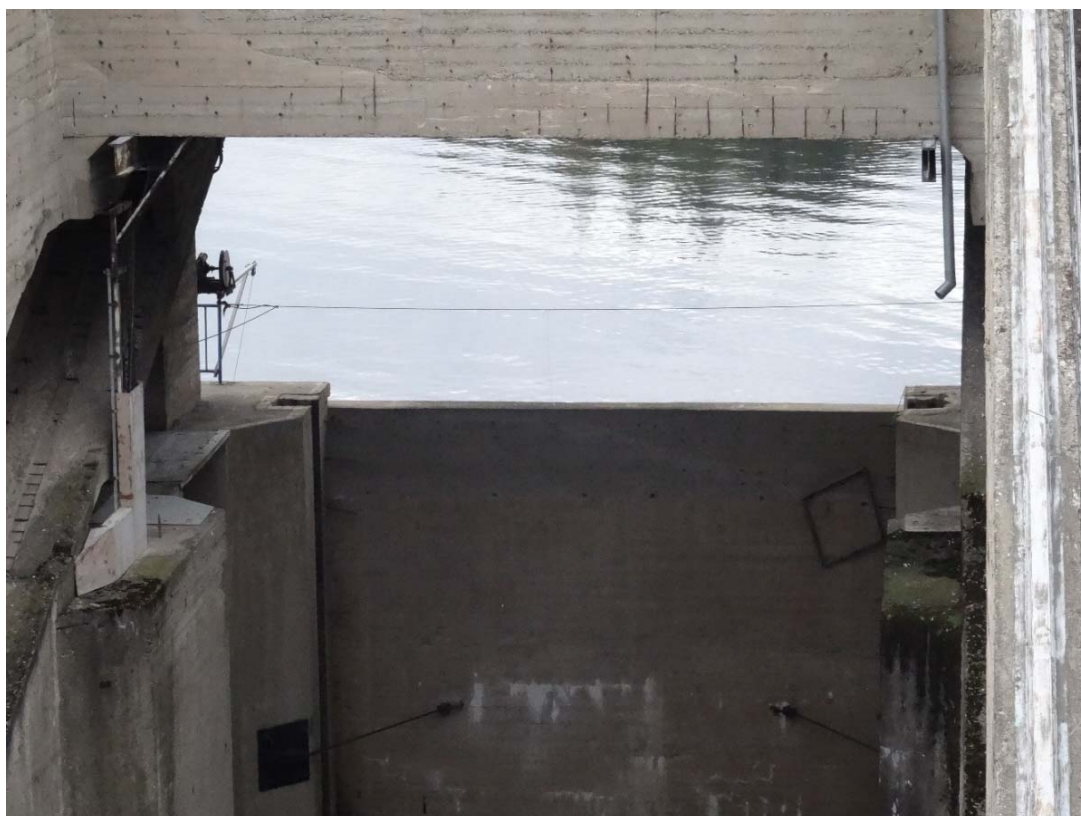
Obr. 4 Otvor v čele stavební části nedokončeného lodního zdvihadla [1] – v rámci posudku se nepodařilo zjistit, zda je tento otvor při povodni hrazen, či zda funguje jako „nouzový přeliv“
