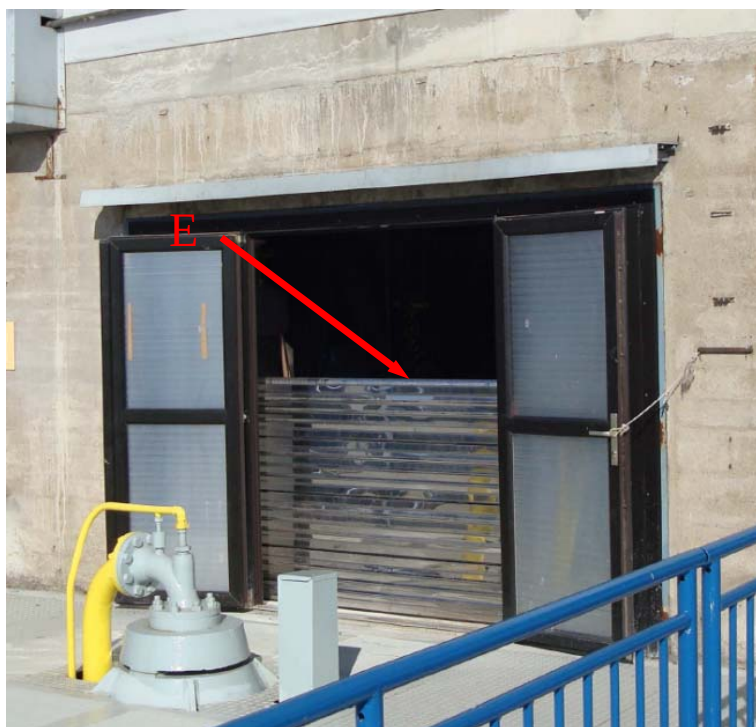
Obr. 6 Hliníková hradítka instalovaná ve dveřích v piliři u bezpečnostního přelivu [12] E - mobilní hliníková hradítka
