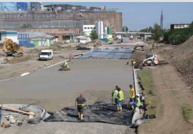
▲ Obr. 12. Stavba komunikací
