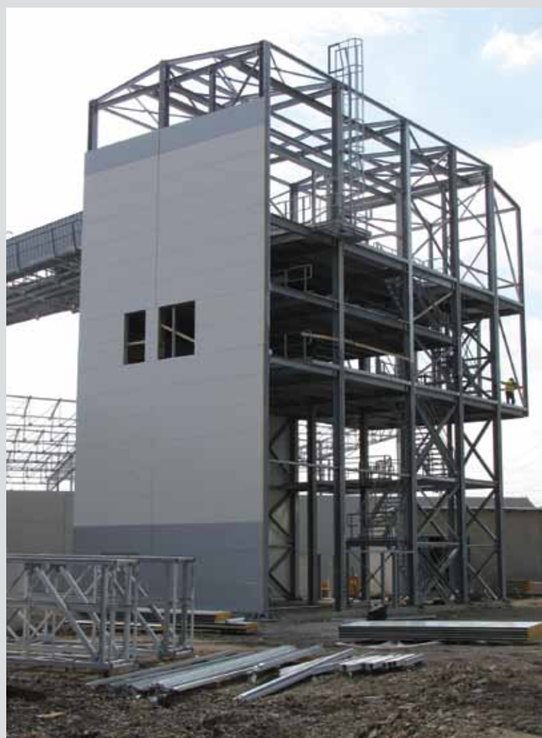
▲ Obr. 10. Ocelová konstrukce přesýpací věže
