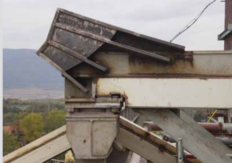
▲ Obr. 7. a 8. Předpínání a zesílení stávajících ocelových příhradových vazníků na střeše bloku, 2x18 lan, přetížení více jak 180 t
