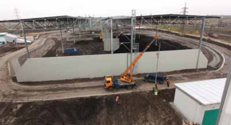
▲ Obr. 11. Zastřešení skládky
