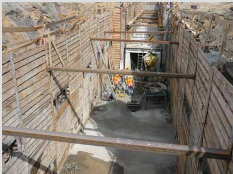
▲ Obr. 5. Celkový pohled na rozestavěný vyhrnovací tunel
