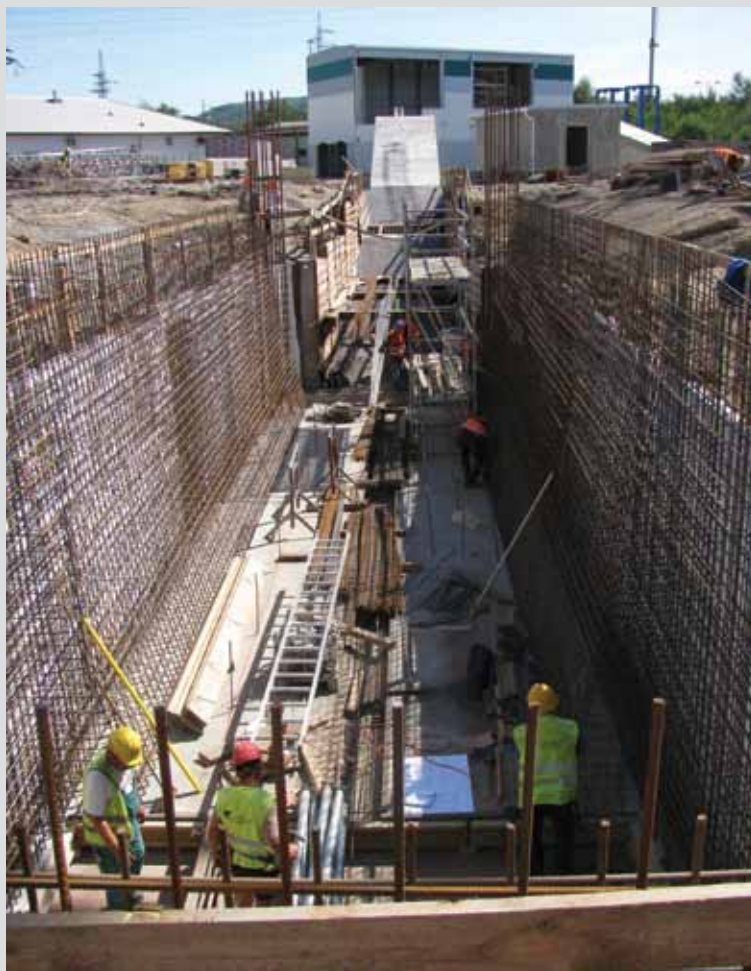
▼ Obr. 6. Realizace nakládacího zásobníku
