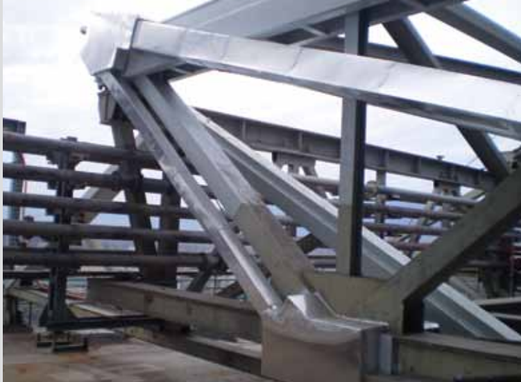
▲ Obr. 7. a 8. Předpínání a zesílení stávajících ocelových příhradových vazníků na střeše bloku, 2x18 lan, přetížení více jak 180 t
