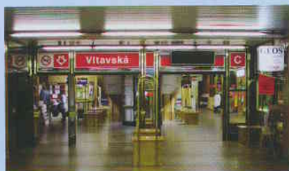
Obr. 6: Stanice Vltavská, lavičky na podlaze vestibulu zakrývají zhlaví kotev
