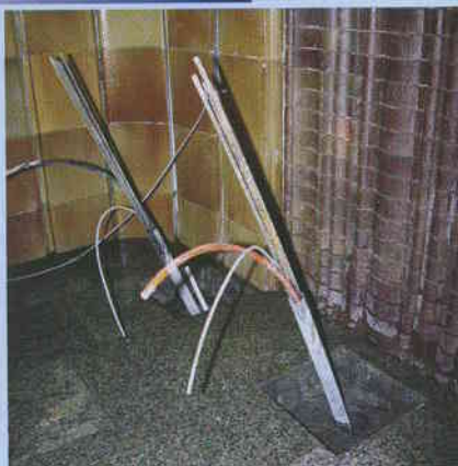
Obr. 5: Stanice Vltavská, osazené pramencové kotvy před napnutím
