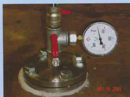
Obr. 8: Stanice Vltavská – základová deska, zařízení pro měření tlaku na základovou desku (Foto: Kloknerův ústav ČVUT)
