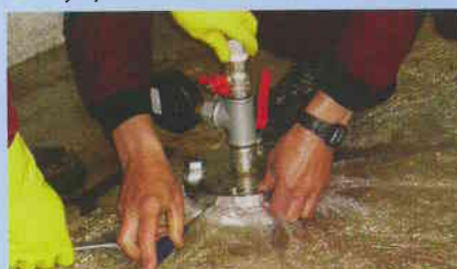
Obr. 7: Stanice Vltavská – základová deska, instalace měřicího zařízení po provrtání izolačního souvrství (Foto: Kloknerův ústav ČVUT)
