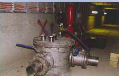
Obr. 15: Stanice Florenc C. Vystrojené tlakově odolné zhlaví odlehčovacího prvku, zabudované do základové desky.
