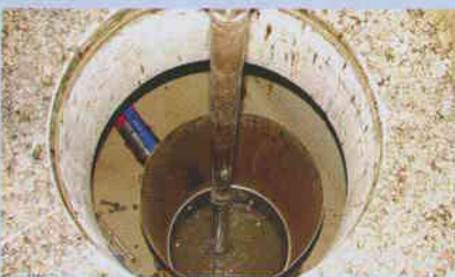
Obr. 13: Stanice Florenc C – pohled z nástupiště. Provádění HG vrtu pro čerpací zkoušku skrz hermeticky osazené zhlaví odlehčovacího prvku s odvedením průsaků do bočního potrubí.
