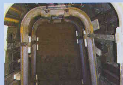
Obr. 10: Stanice Malostranská, ražba drenážní štol podél vnější stěny vestibulu
