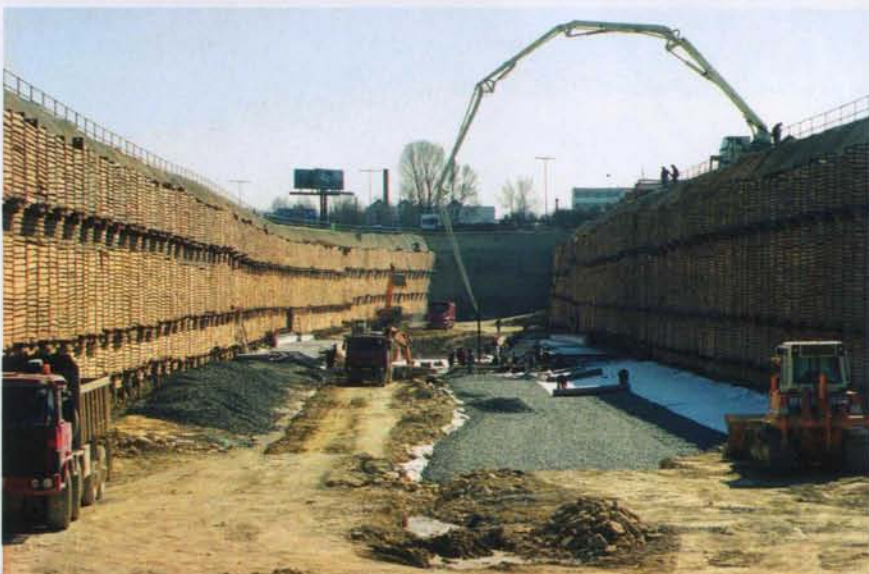
Zajištění jámy stanice metra záporovým pažením, pohled směrem k portálu ražených tunelů
