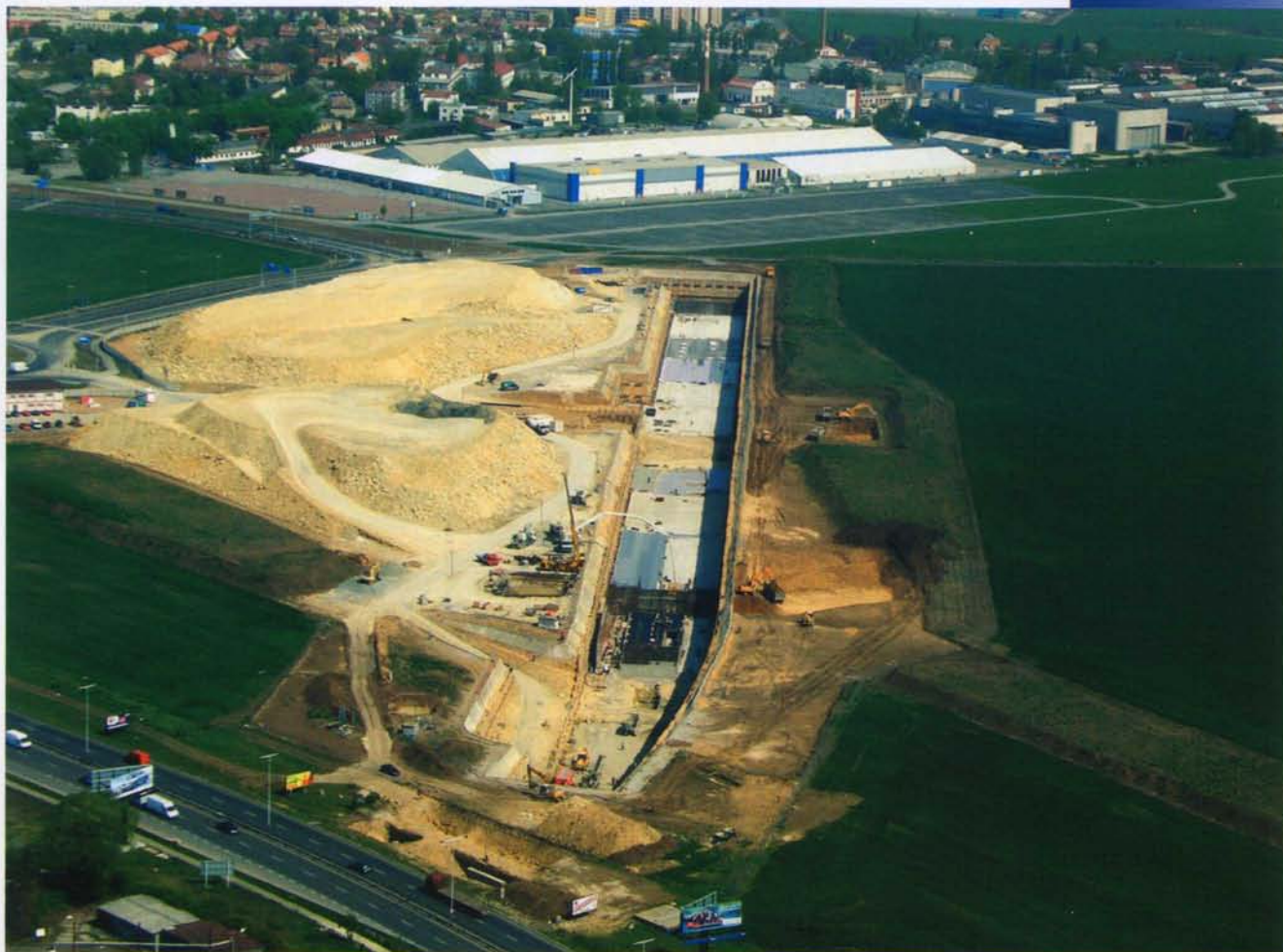
Letecký pohled na stavební jámu stanice Letňany (Foto: Subterra, a. s.)
