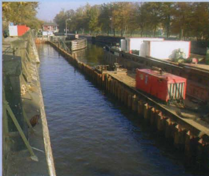
Štětová stěna jímky po doberanění před vyčerpáním vody
