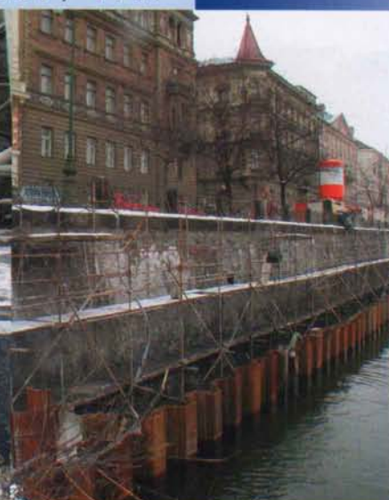
Celkový pohled na pracoviště při opravě zdi
