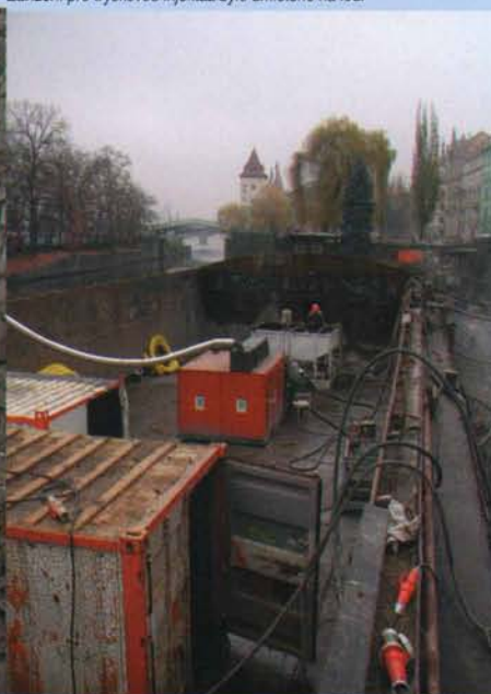
Zařízení pro tryskovou injektáž bylo umístěno na lodě
