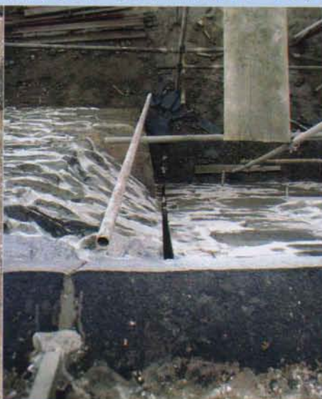
Pohled z chodníku dolů na nově proříznutou dilatační spáru.
