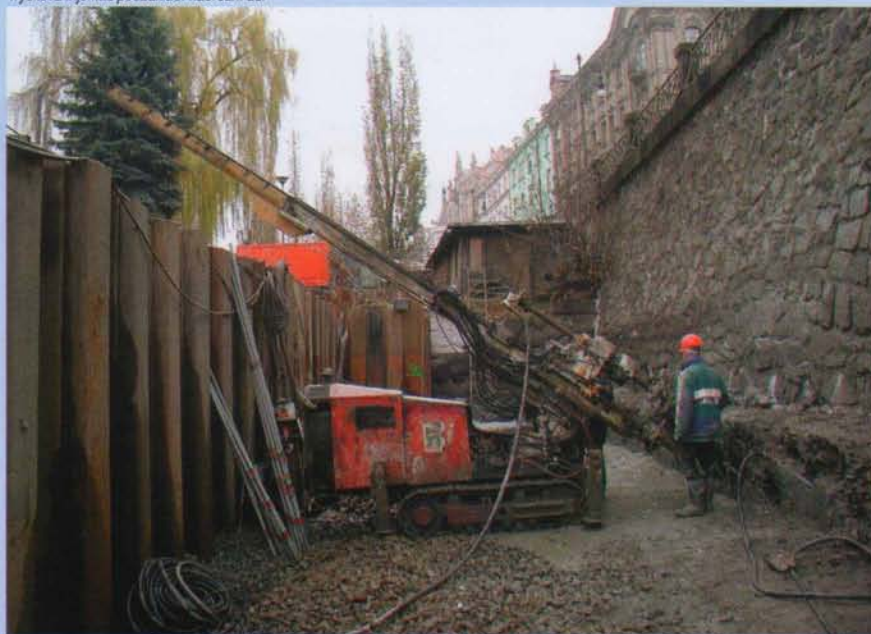
Trysková injektáž podzákladí nábrežní zdi
