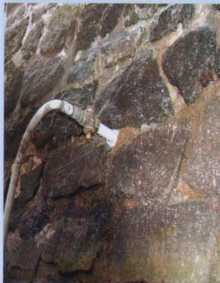
Napojení injekční hadice při plošné injektáži zdi
